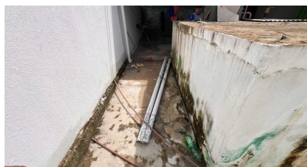
Foto 20: Reservatório de água
