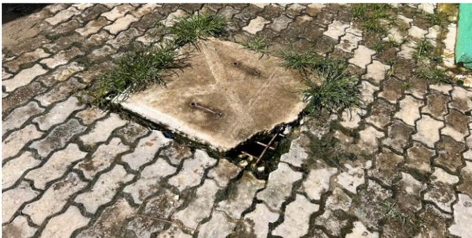
FOTO 05: Caixa de esgoto saturada
