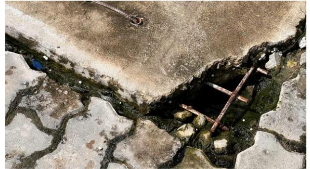
FOTO 04: Caixa de esgoto saturada
