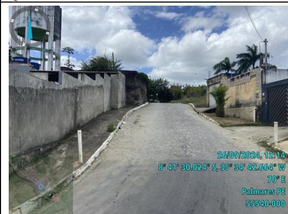
Foto 05: Pavimentação Asfáltica – Bairro: Quilombo I
