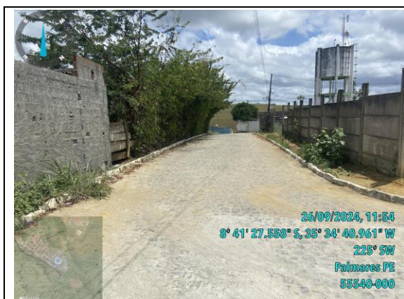
Foto 07: Pavimentação Asfáltica – Bairro: Quilombo I
