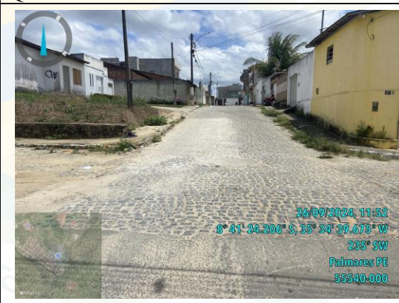
Foto 12: Pavimentação Asfáltica – Bairro: Quilombo I
