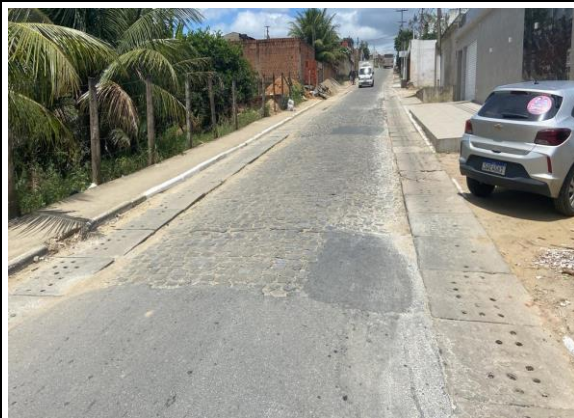
Foto 01: Pavimentação Asfáltica – Bairro: Quilombo I
