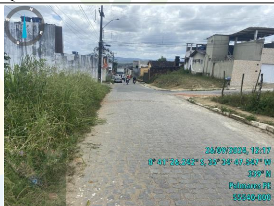
Foto 04: Pavimentação Asfáltica – Bairro: Quilombo I
