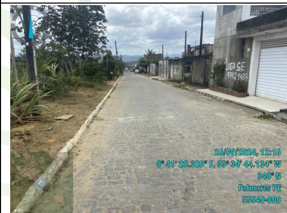
Foto 03: Pavimentação Asfáltica – Bairro: Quilombo I
