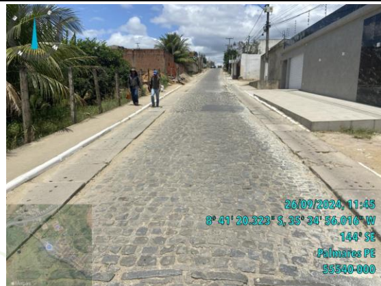
Foto 02: Pavimentação Asfáltica – Bairro: Quilombo I
